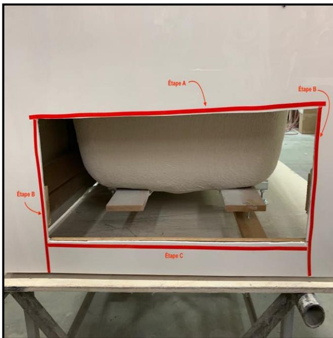
A) Appliquer le ruban double face au-dessus de l'ouverture horizontale. Ne pas excéder de plus de  $\frac{3}{4}$ " de chaque côté de la trappe.
