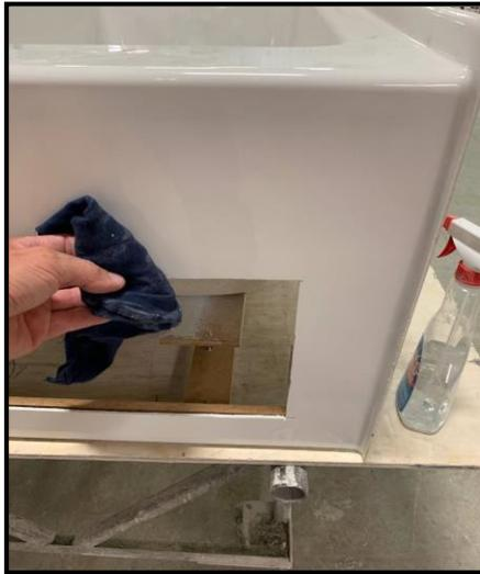
B) Nettoyer à l'aide d'un chiffon propre et de l'alcool de bois le pourtour intérieur la trappe d'installation.
